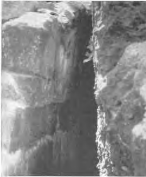
12. MIDDLE PIER: WEST SIDE.
